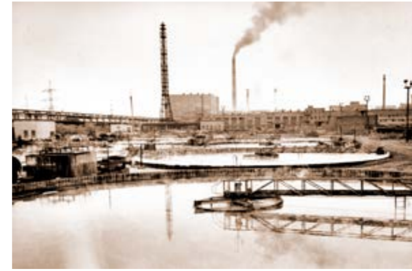
Прежде чем водные стоки окажутся в Северной Двине, на ПБО они проходят несколько сложных механических и биологических стадий очистки
