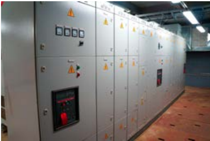
Строительство главных объектов модернизации Архангельского ЦБК – цеха по производству полуцеллюлозы и котлоагрегата №8
